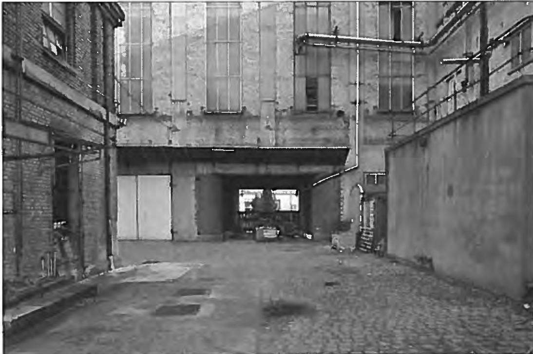
Bild 50 Ansicht von Südwesten. Durchfahrt
