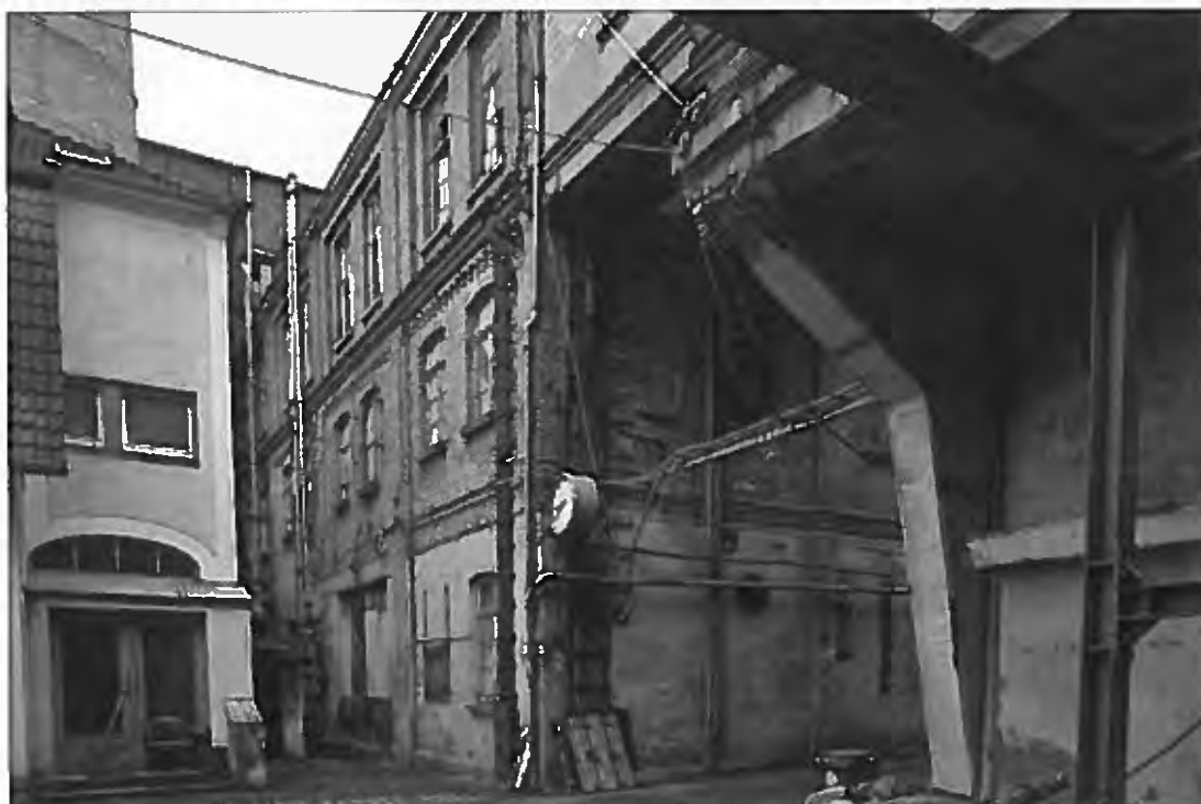
Bild 21 Ansicht von Norden
