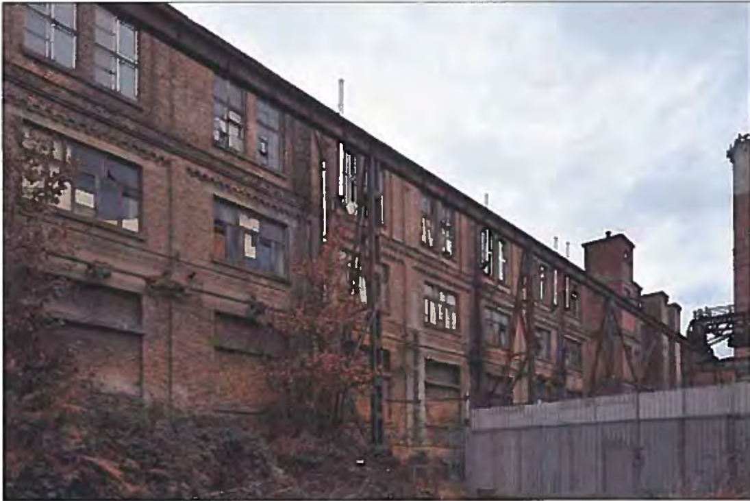
Bild 33 Ansicht von Südwesten
