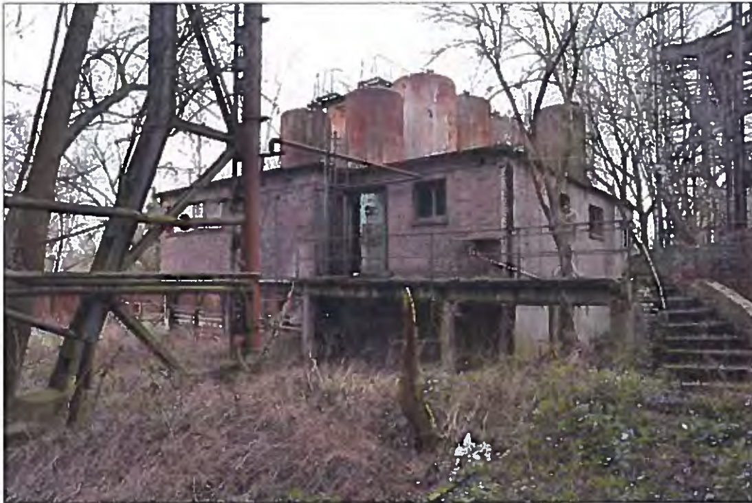
Bild 67 Ansicht von Norden
