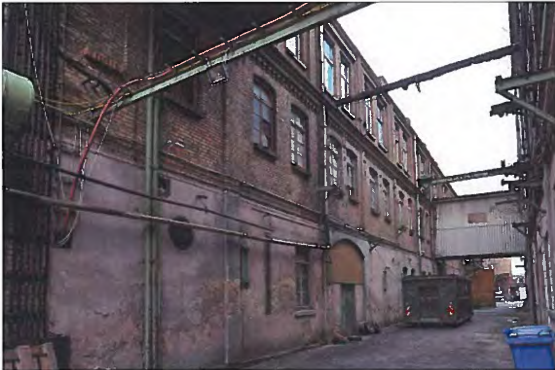
Bild 01 Ansicht von Nordosten
