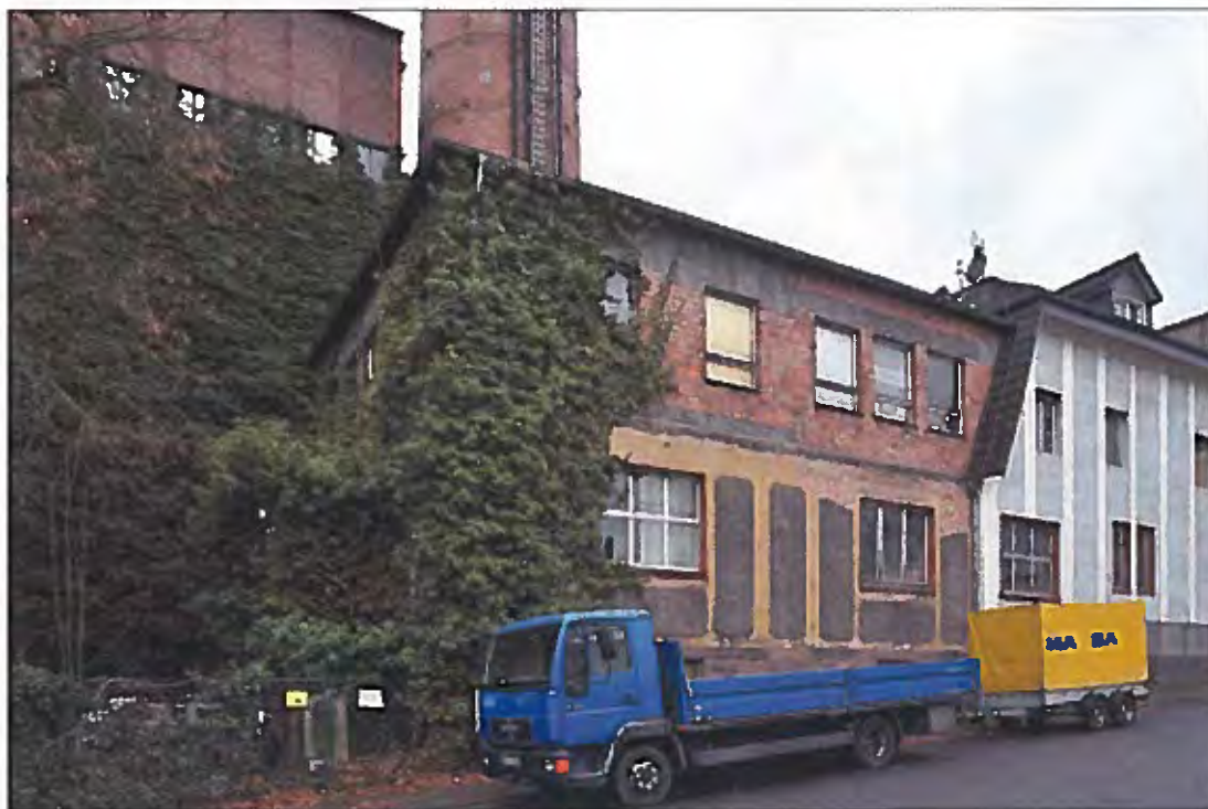
Bild 15 Ansicht von Osten
