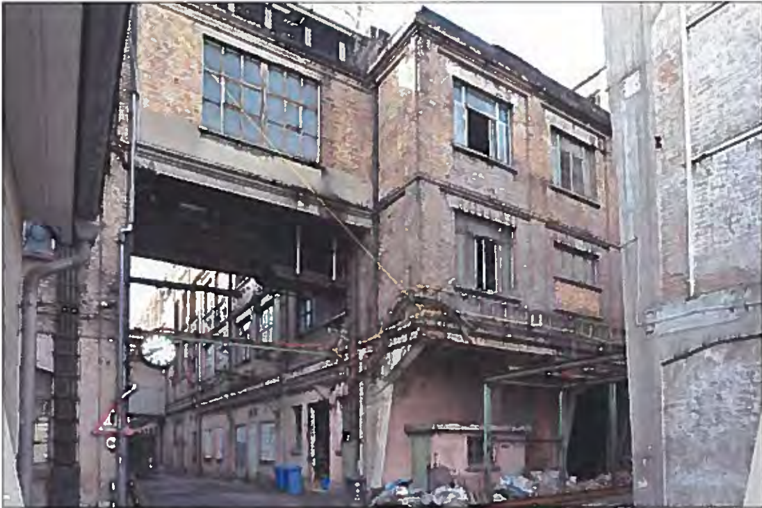
Bild 07 Ansicht von Osten
