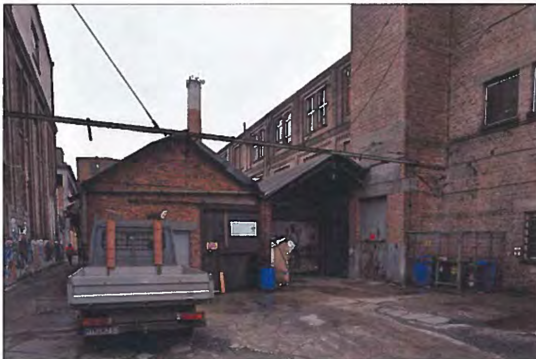
Bild 11 Ansicht von Südwesten
