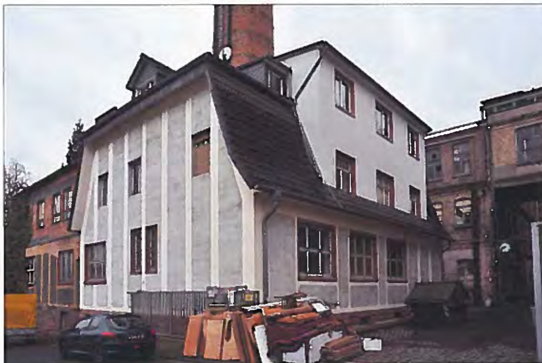
Bild 13 Ansicht von Nordosten
