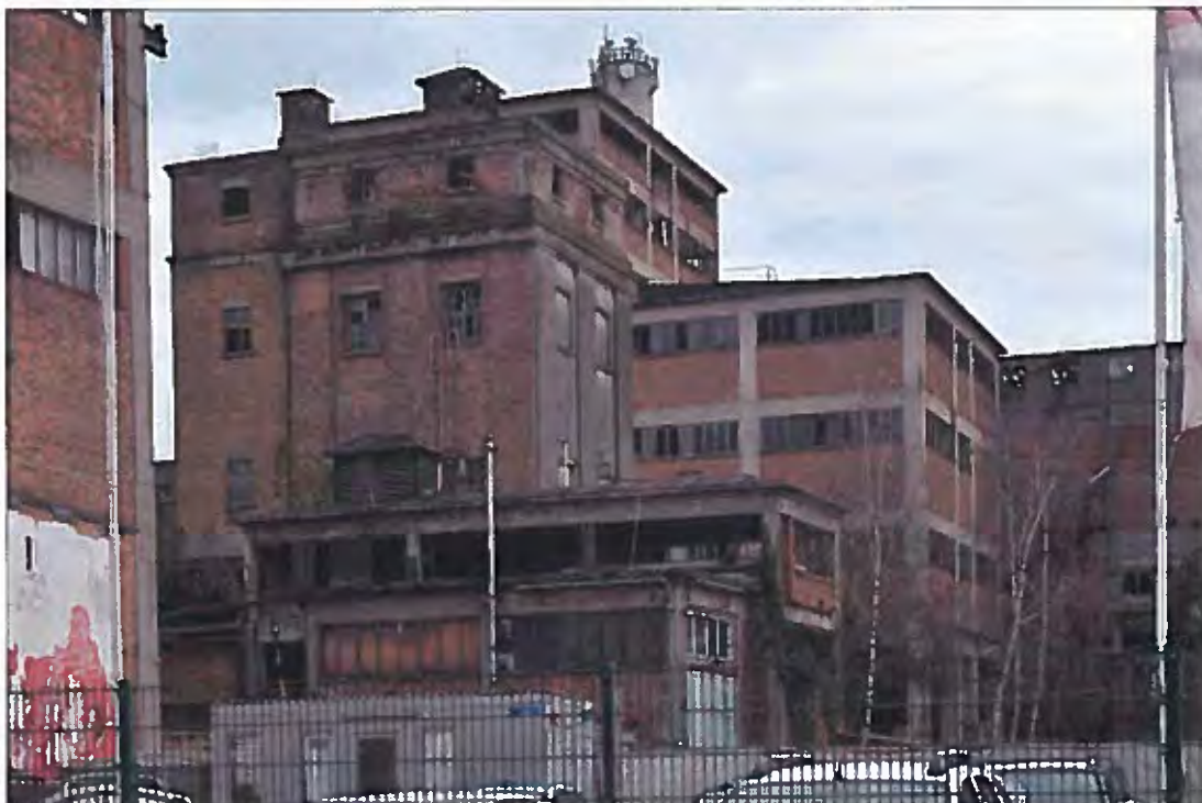
Bild 42 Ansicht von Norden
