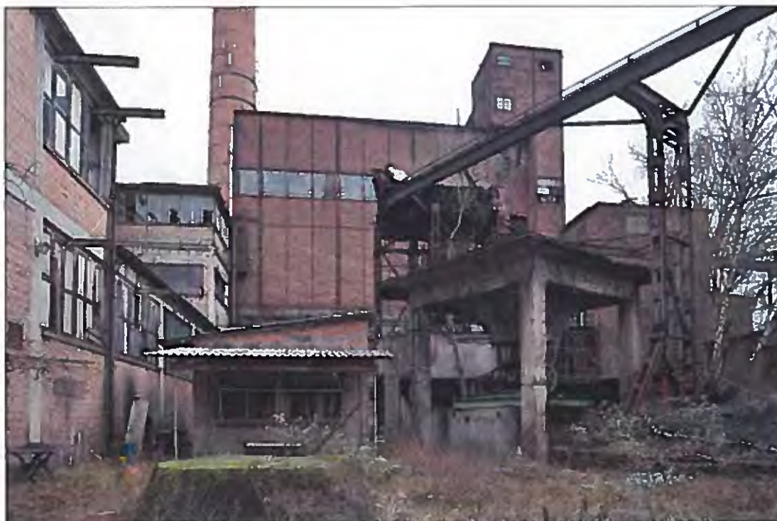
Bild 43 Ansicht von Südwesten
