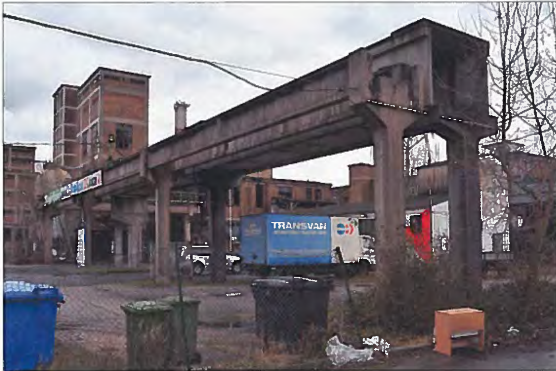
Bild 58 Ansicht von Nordwesten
