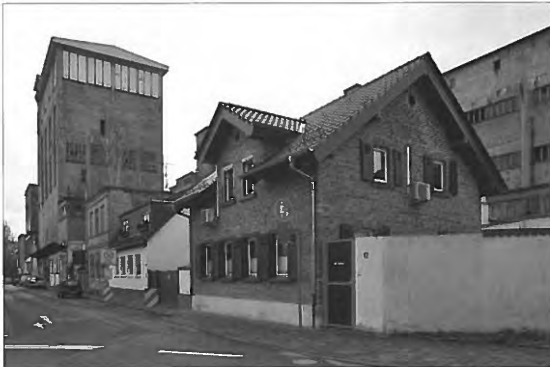
Bild 18 Ansicht von Norden
