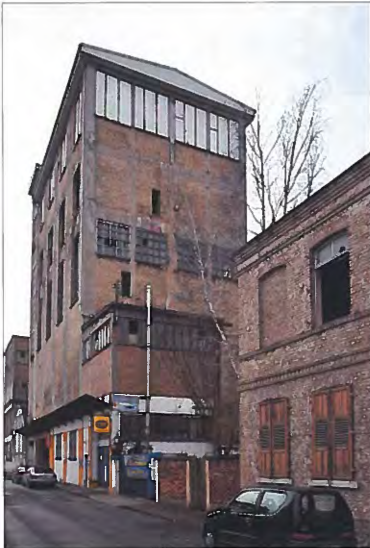
Bild 47 Ansicht von Nordosten
