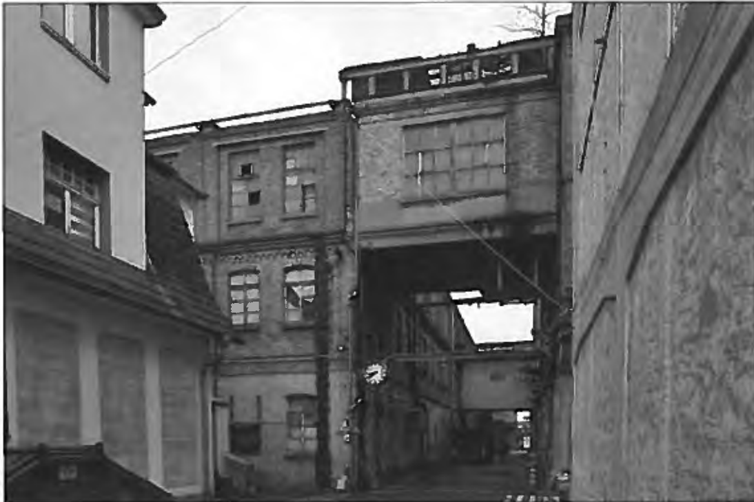
Bild 20 Ansicht von Nordosten
