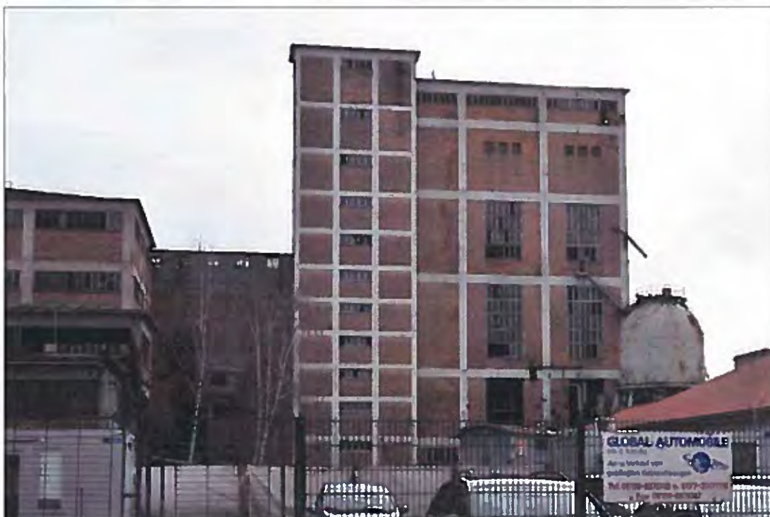
Bild 75 Ansicht von Norden
