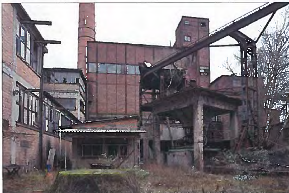
Bild 27 Ansicht von Südwesten
