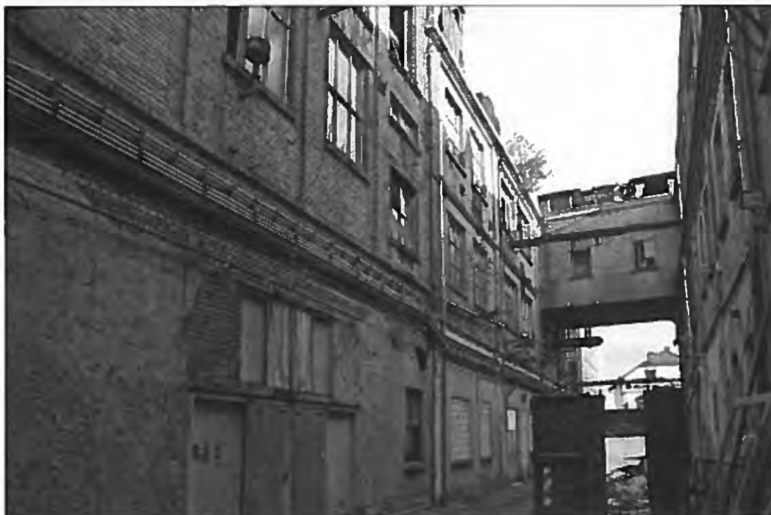
Bild 10 Ansicht von Südwesten
