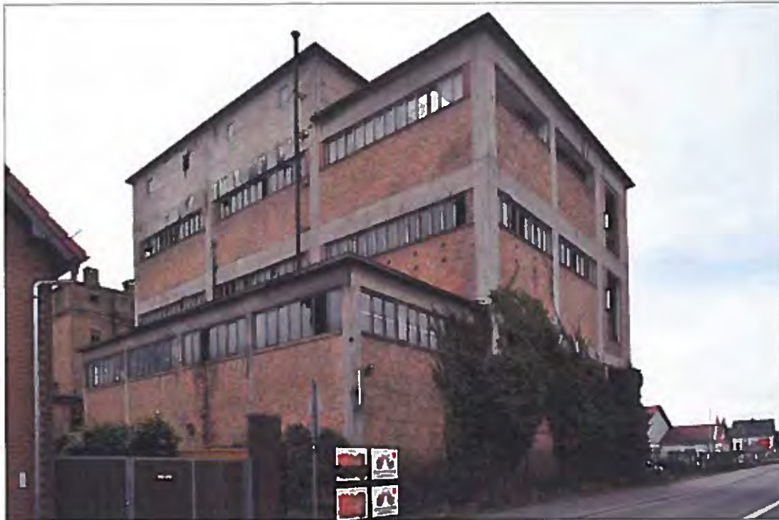
Bild 64 Ansicht von Norden
