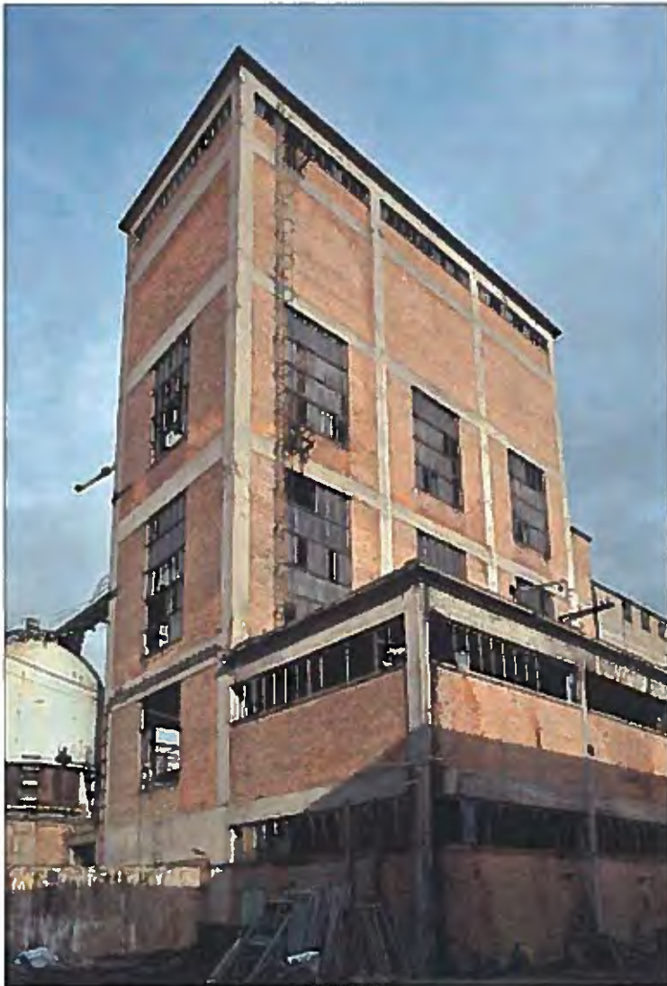
Bild 60 Ansicht von Südwesten
