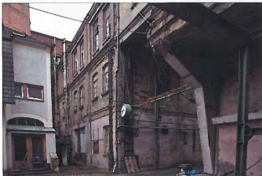
Bild 14 Ansicht von Norden. Eingang
